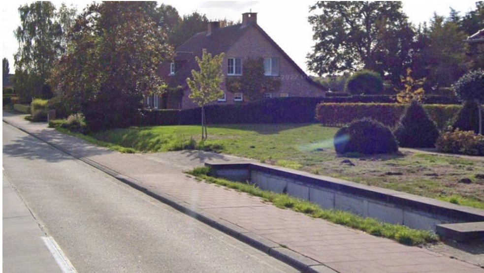
Figuur 7-18 : Baangracht in de Smidstraat, als voorbeeld voor de willekeur waarop de inrichting ervan in dezelfde straat gebeurt. Deels ingebuisd en deels open met verharde wanden (en bodem) onderbreekt de meer natuurlijke gracht .
