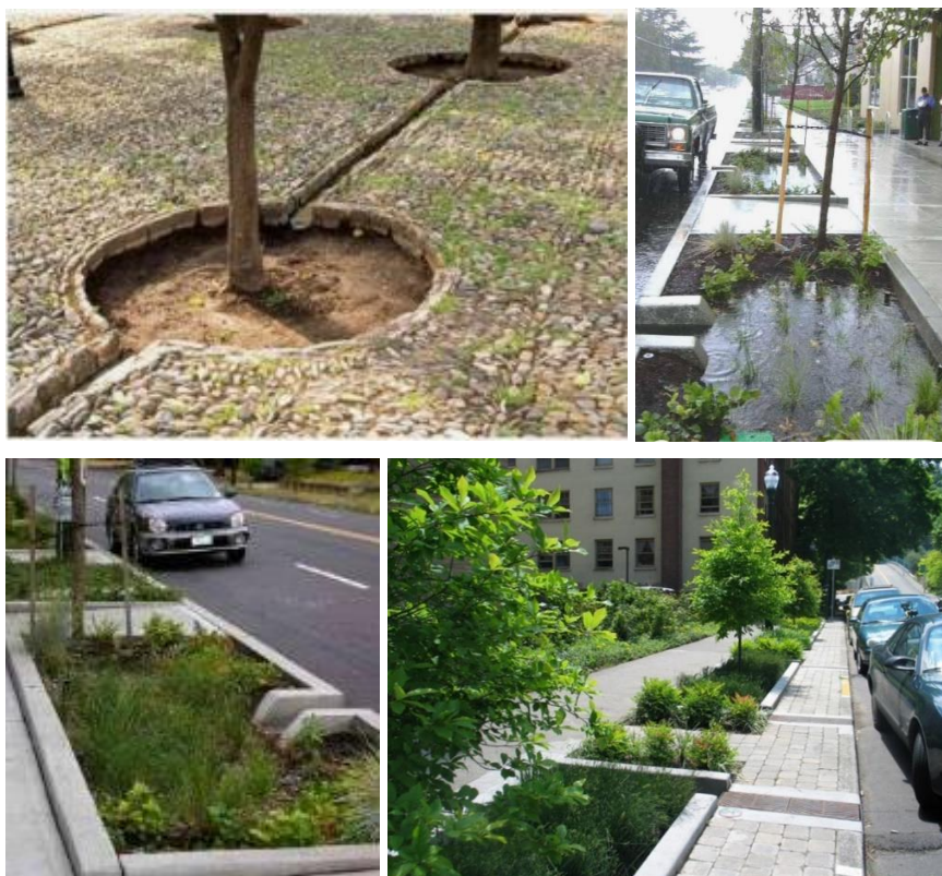
Figuur 7-5: Voorbeelden van verlaagde bermen, plantvakken en groenzones en de aanpassing van boordsteen voor verbeterde infiltratie
