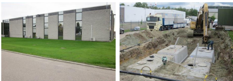
Figuur 7-15 : Voorbeelden van het bovengronds (links; bron: Vlario, 2014) of ondergronds bufferen (rechts; bron: Vlario, 2014)
