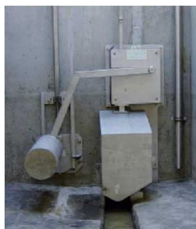
Figuur 7-17 : voorbeeld van een Hydroslide debietbegrenzer (onderaan; bron: Steinhardt Wassertechnik GmbH, n.d.)
