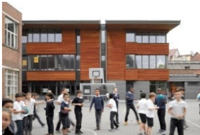
Figuur 7-30 : de IMMI school te Anderlecht waar hemelwater opgevangen wordt en gereinigd tot drinkwater (bron: Gids Duurzame Gebouwen .brussels, n.d.)
