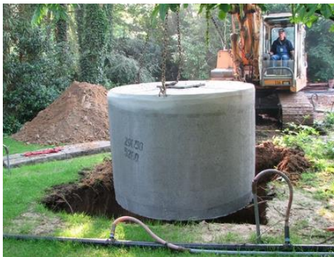
Figuur 7-27 : Het plaatsen van een hemelwaterput voor het opvangen en hergebruiken van hemelwater
