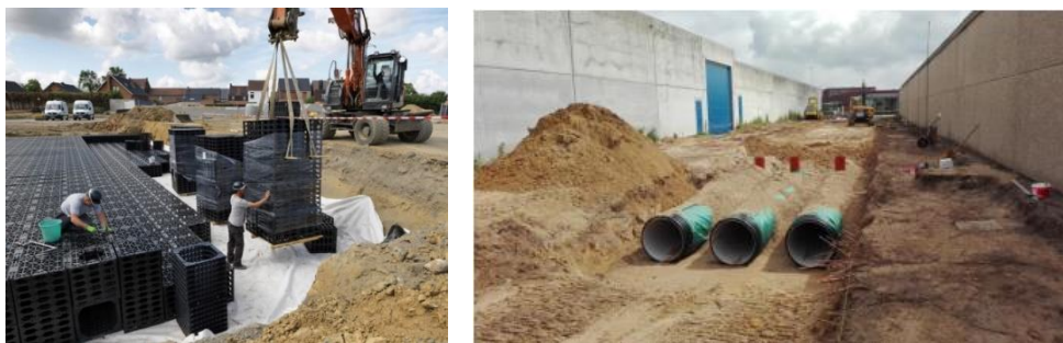
Figuur 7-9 : Voorbeelden van ondergrondse infiltratie met kratten (links; bron: Pidpa) en infiltratieleidingen (rechts; bron: Vlario, 2017))
