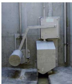
Figuur 7-17 : voorbeeld van een Hydroslide debietbegrenzer (onderaan; bron: Steinhart Wassertechnik GmbH, n.d.)
