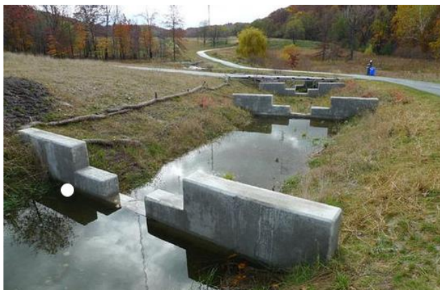
Figuur 7-4 : Voorbeelden van baangrachten gecompartmenteerd door middel van betonnen stuwen met overloopprefiel. Dergelijke stuwen zijn te verkiezen boven knijpconstructies met een opening onderaan
