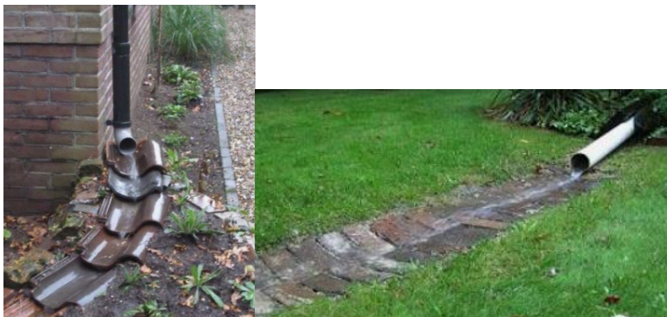
Figuur 7-8 Voorbeelden van afkoppeling van de regenwaterafvoer van woningen richting de private tuin.
