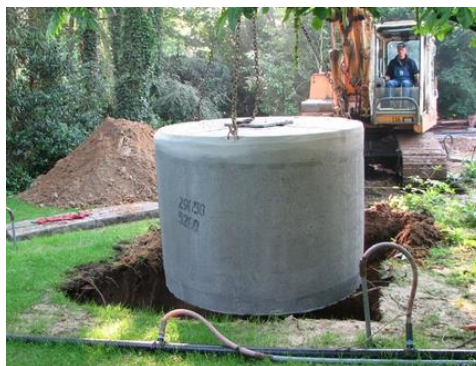
Figuur 7-29 : Het plaatsen van een hemelwaterput voor het opvangen en hergebruiken van hemelwater
