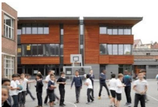
Figuur 7-32 : de IMMI school te Anderlecht waar hemelwater opgevangen wordt en gereinigd tot drinkwater (bron: Gids Duurzame Gebouwen .brussels, n.d.)
