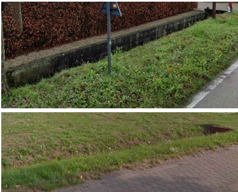
Figuur 7-19 : Baangracht in de Liersesteenweg, als voorbeeld voor de willekeur waarop de inrichting ervan in dezelfde straat gebeurt. Boven: deels ingebuisd en deels open met verharde wanden (en bodem); onder: gracht als een blauwgroene as langs de straat.
