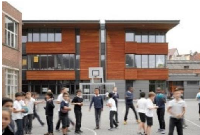
Figuur_Bijlage D-3: de IMMI school te Anderlecht waar hemelwater opgevangen wordt en gereinigd tot drinkwater (bron: Gids Duurzame Gebouwen .brussels, n.d.)
