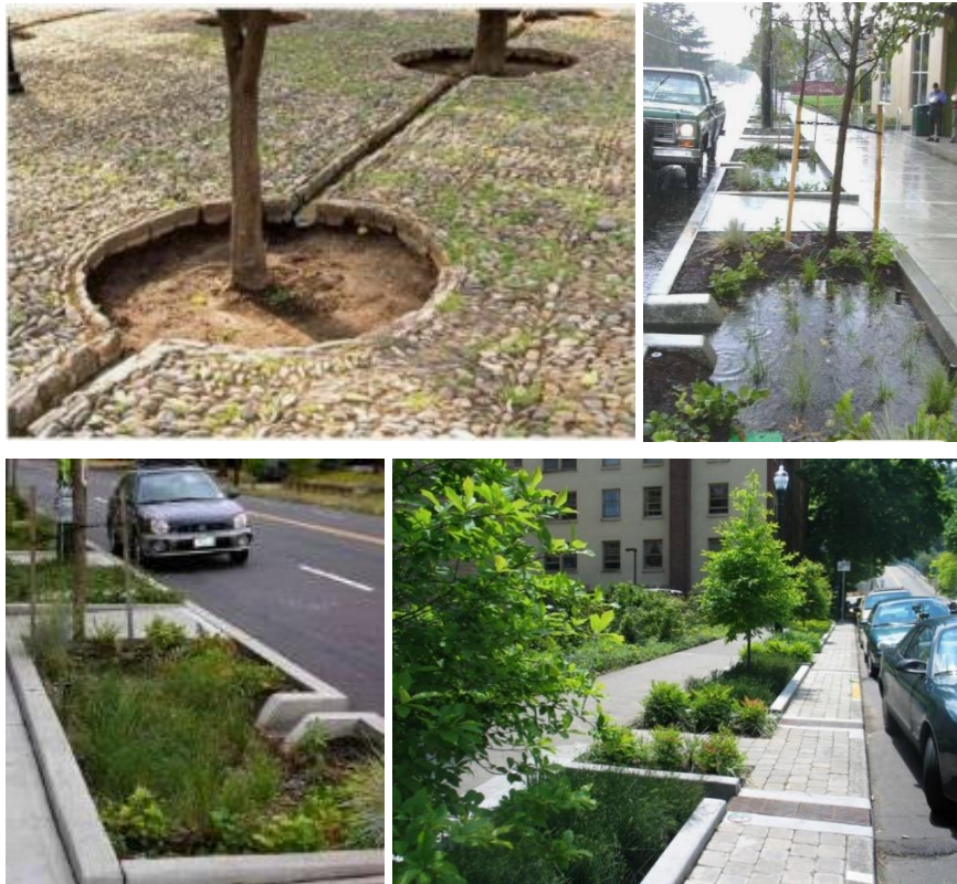
Figuur_Bijlage D-5: Voorbeelden van verlaagde bermen, plantvakken en groenzones en de aanpassing van boordstenen voor verbeterde infiltratie
