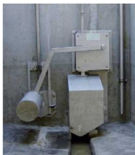
Figuur_Bijlage D-13: voorbeeld van een Hydroslide debietbegrenzer (onderaan; bron: Steinhardt Wassertechnik GmbH, n.d.)
