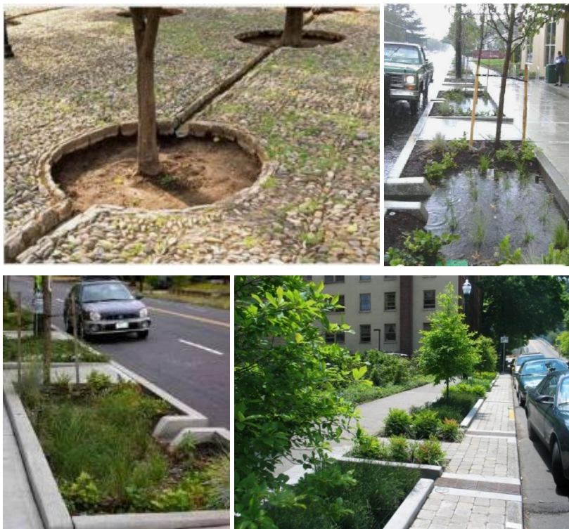
Figuur_Bijlage D-5: Voorbeelden van verlaagde bermen, plantvakken en groenzones en de aanpassing van boordstenen voor verbeterde infiltratie
