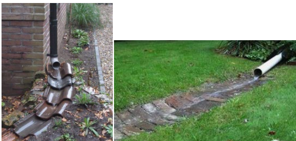
Figuur 7-9 : Voorbeelden van afkoppeling van de regenwaterafvoer van woningen richting de private tuin.
