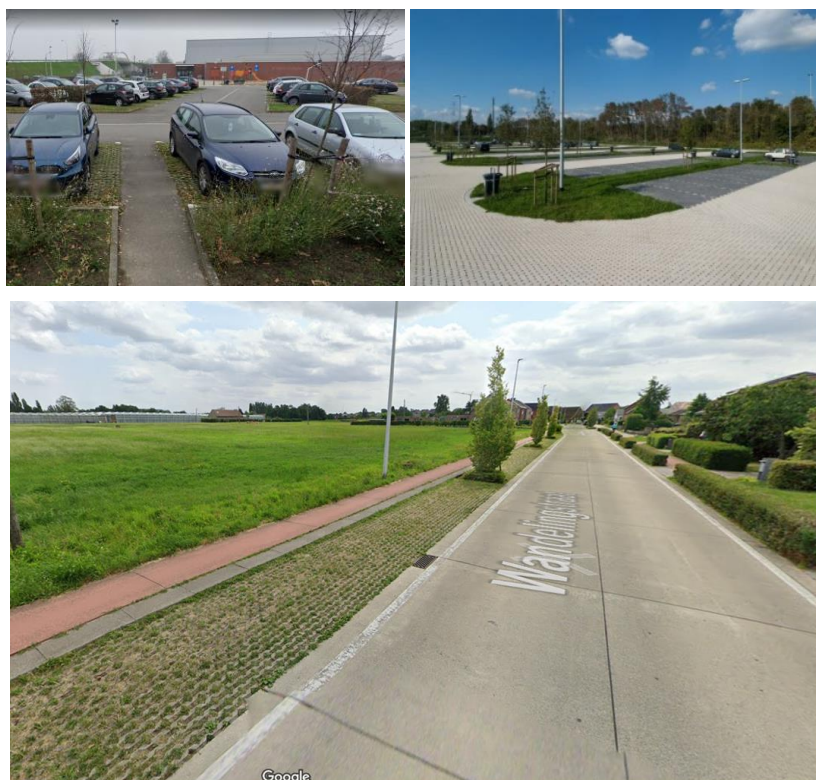
Figuur 7-2 : Voorbeelden van het toepassen van ontharden op de parking van de sporthal Rooienberg te Duffel (linksboven; bron: google maps), een carpoolparking te Hasselt (rechtsboven ; bron: foto Ebema) en, een voorbeeld van ontharde parkeerstroken van de Wandelingsstraat te Duffel (bron: google maps)
