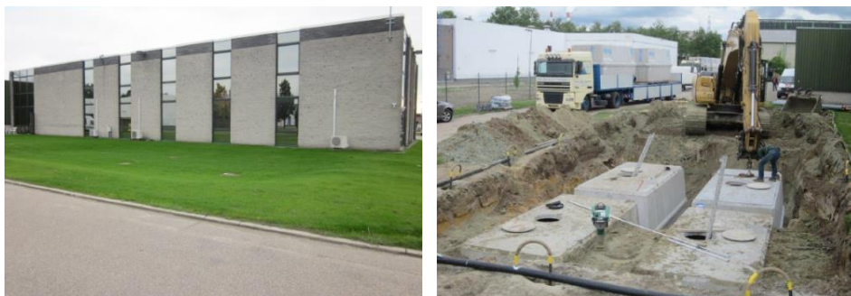
Figuur 7-16 : Voorbeelden van het bovengronds (links; bron: Vlario, 2014) of ondergronds bufferen (rechts; bron: Vlario, 2014)
