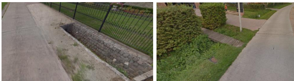
Figuur 7-20 : Baangracht in de Enkelstraat, als voorbeeld voor de willekeur waarop de inrichting ervan in dezelfde straat gebeurt. Links: deels ingebuisd en deels open met verharde wanden (en bodem); rechts: gracht als een blauwgroene as langs de straat.
