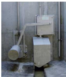
Figuur 7-18 : voorbeeld van een Hydroslide debietbegrenzer (onderaan; bron: Steinhart Wassertechnik GmbH, n.d.)
