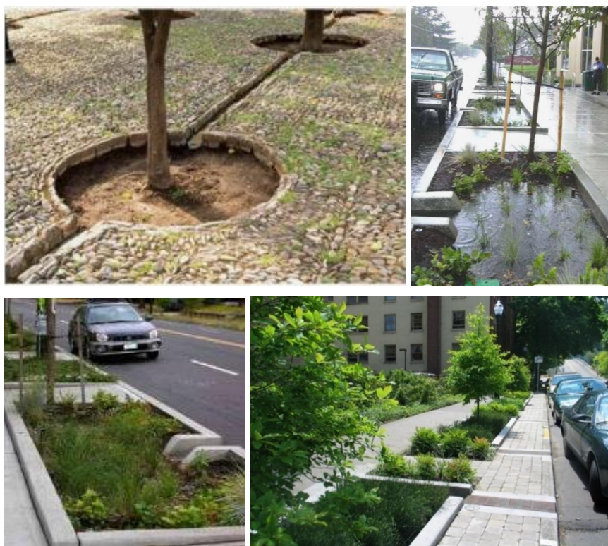
Figuur 7-6: Voorbeelden van verlaagde bermen, plantvakken en groenzones en de aanpassing van boordsteen voor verbeterde infiltratie
