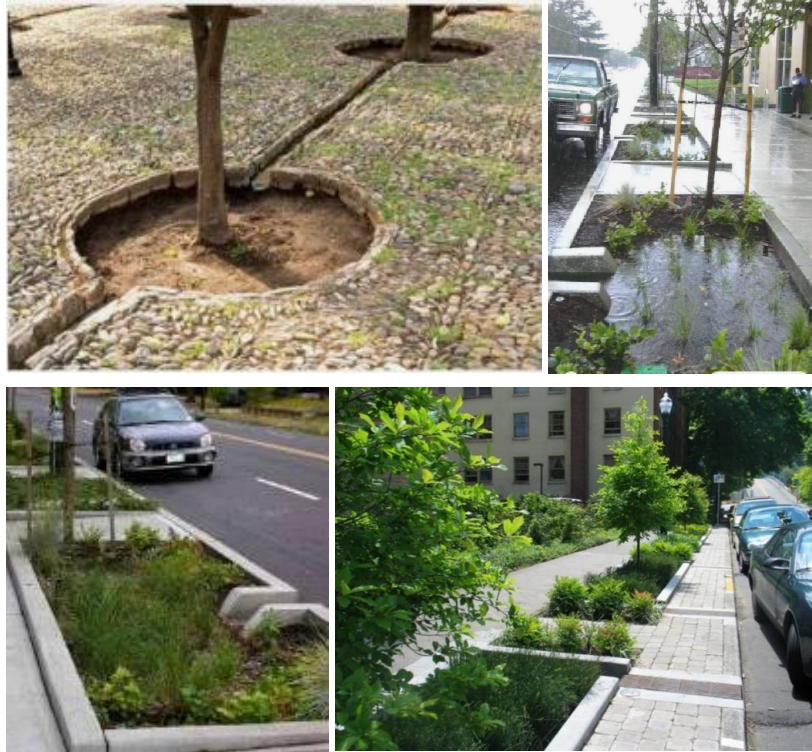
Figuur 7-5: Voorbeelden van verlaagde bermen, plantvakken en groenzones en de aanpassing van boordsteen voor verbeterde infiltratie
