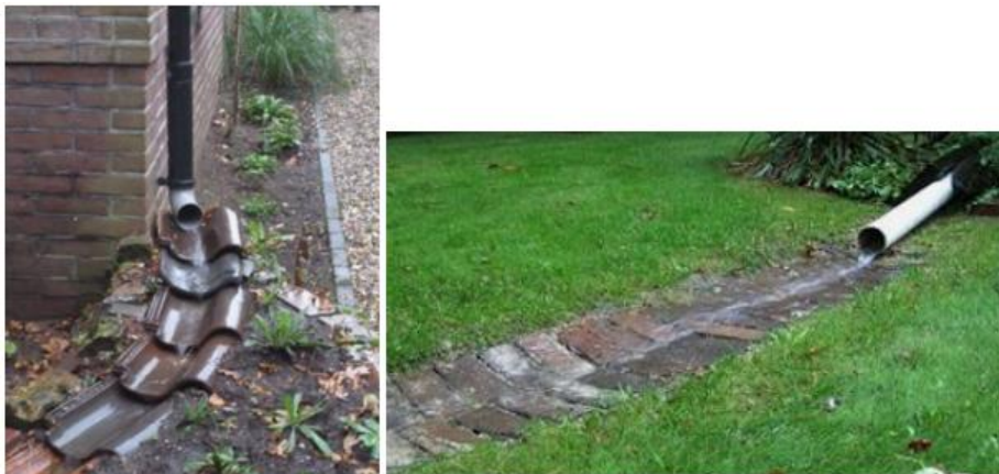
Figuur 7-7 Voorbeelden van afkoppeling van de regenwaterafvoer van woningen richting de private tuin.
