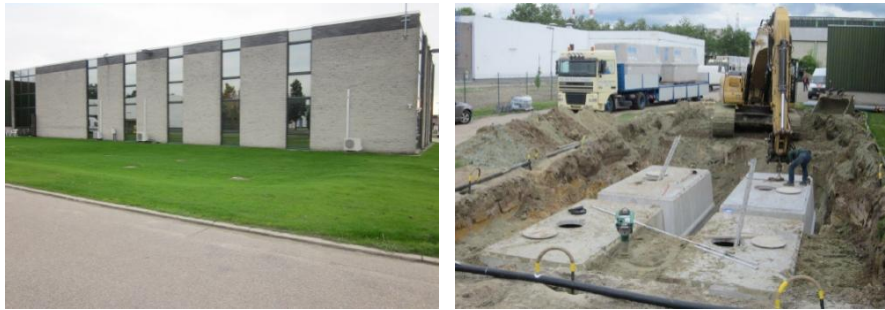
Figuur 7-13 : Voorbeelden van het bovengronds (links; bron: Vlario, 2014) of ondergronds bufferen (rechts; bron: Vlario, 2014)
