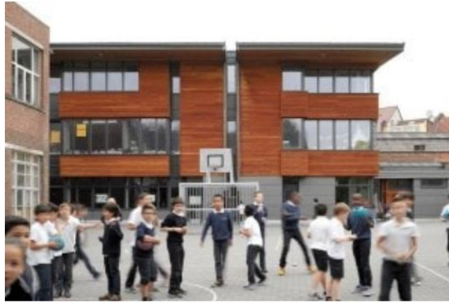
Figuur 7-27 : de IMMI school te Anderlecht waar hemelwater opgevangen wordt en gereinigd tot drinkwater (bron: Gids Duurzame Gebouwen .brussels, n.d.)
