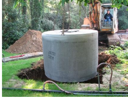
Figuur 7-24 : Het plaatsen van een hemelwaterput voor het opvangen en hergebruiken van hemelwater
