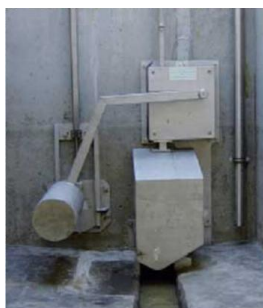
Figuur 7-15 : voorbeeld van een Hydroslide debietbegrenzer (onderaan; bron: Steinhardt Wassertechnik GmbH, n.d.)
