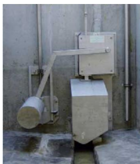
Figuur 7-17 : voorbeeld van een Hydroslide debietbegrenzer (onderaan; (Wassertechnik, (n.d.)))
