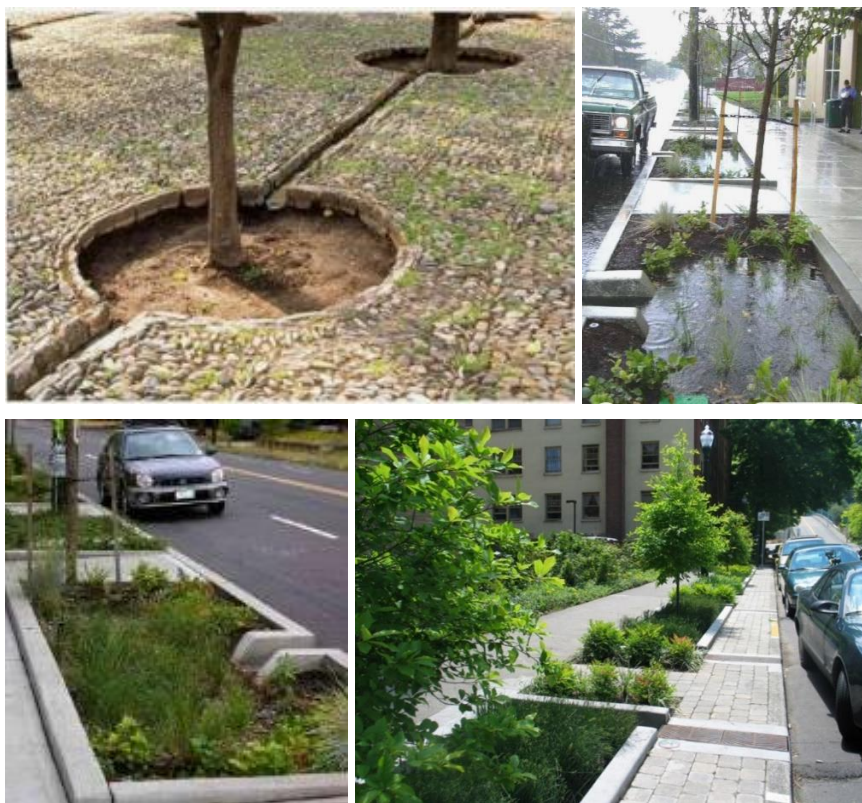
Figuur 7-5 : Voorbeelden van verlaagde bermen, plantvakken en groenzones en de aanpassing van boordstenen voor verbeterde infiltratie
