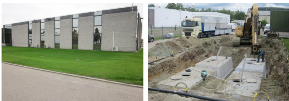
Figuur 7-15 : Voorbeelden van het bovengronds of ondergronds bufferen (Vlario, 2014)
