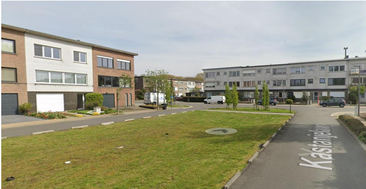
Figuur 16. Infiltrerende groenzone aan de Kastanjelaan. De open drempels zorgen ervoor dat water van de straat en aanpalende verharding in de groenzone kan stromen. Doordat de kolk in de groenzone zelf is geplaatst, i.p.v. in de straat zoals meestal het geval is, wordt het water niet al afgevoerd voor het de groenzone kan bereiken. Bron: Google Maps.
