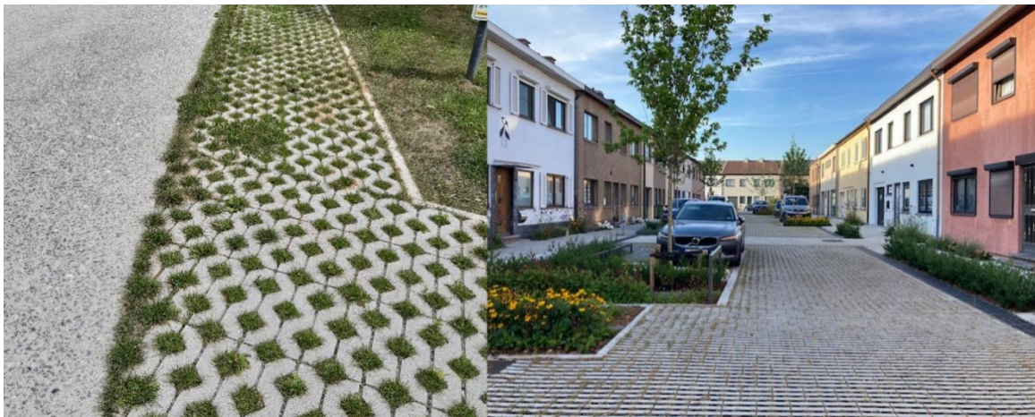
Figuur 20: Vlnr: (1) Versmald voet-fietspad met uitwijkmogelijkheid over waterdoorlatende verharding (Overijse). © Aquafin; (2) Tuinstraat met zowel rijweg als parkeervakken aangelegd in halfverharding (Aziëlaan, Wilrijk). © Aquafin.
