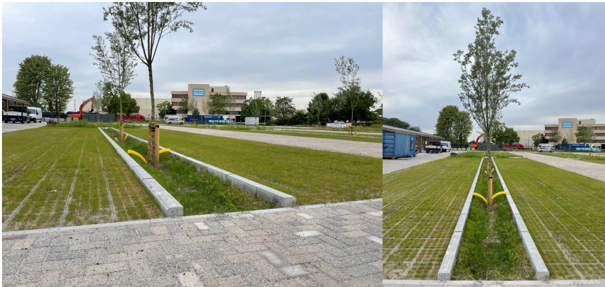
Figuur 24. Voorbeeld van een parking met parkeerplekken uitgevoerd in grasdallen en met een infiltratiestrook in het midden waar al het hemelwater dat op de parking valt, kan infiltreren (Dijkstraat, Aartselaar).
