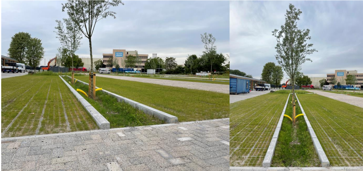
Figuur 15. Voorbeeld van een parking met parkeerplekken uitgevoerd in grasdallen en met een infiltratiestreek in het midden waar al het hemelwater dat op de parking valt, kan infiltreren. © Aquafin.
