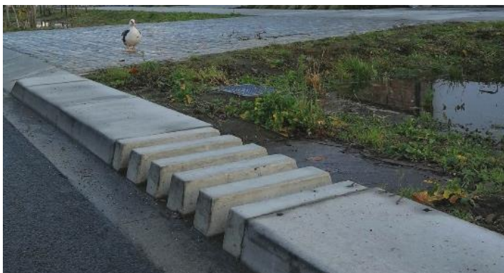
Figuur 28. Een voorbeeld van een boordsteen met spleten zoals toegepast in de Fortstraat in Mortsel (Bron: dbpubliekeruimte.info).
