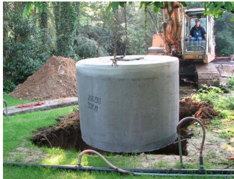
Figuur_Bijlage D-1: Het plaatsen van een hemelwaterput voor het opvangen en hergebruiken van hemelwater
