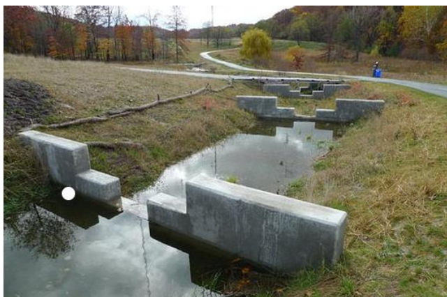
Figuur_Bijlage D-4: Voorbeelden van baangrachten gecompartmenteerd door middel van betonnen stuwens met overloopprofiel. Dergelijke stuwens zijn te verkiezen boven knijpconstructies met een opening onderaan
